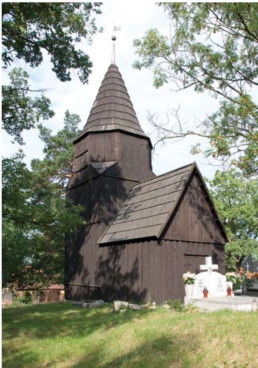
124. Łężyca. Kaplica z 1727 r. o konstrukcji słupowej
