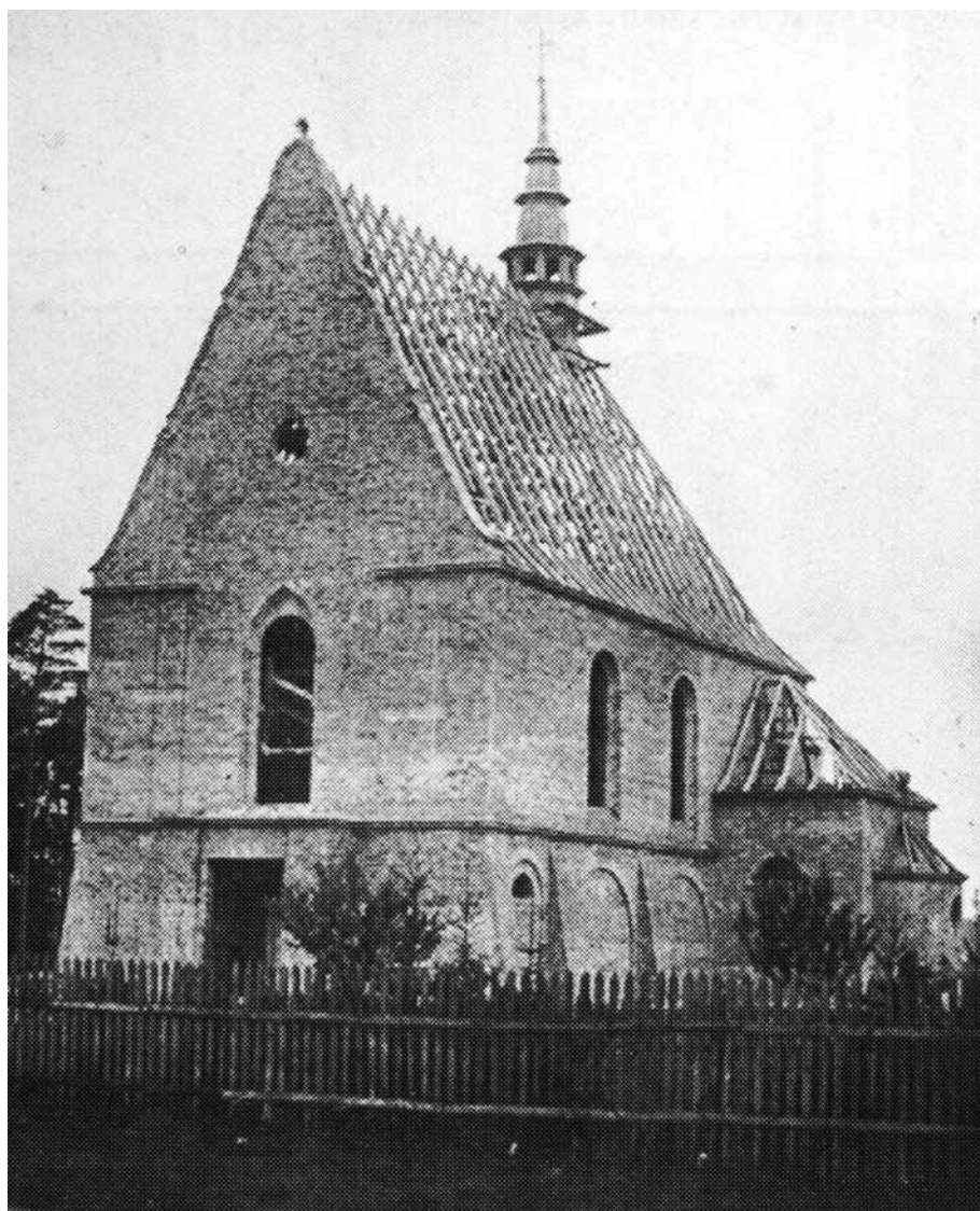
Ryc. 7. Budowa kościoła około 1931 r.
