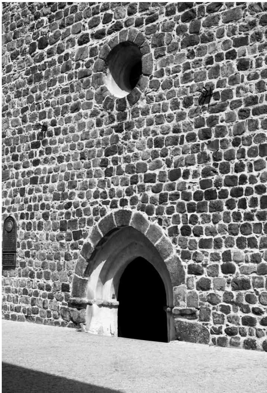
Fot. 8. Lubsko. Kościół parafialny pw. Nawiedzenia Najświętszej Maryi Panny. Fragment najstarszej elewacji. Fot. K. Garbacz
