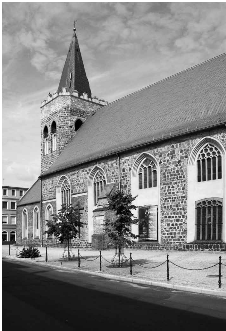
Fot. 7. Lubsko. Kościół parafialny pw. Nawiedzenia Najświętszej Maryi Panny. Fot. K. Garbacz
