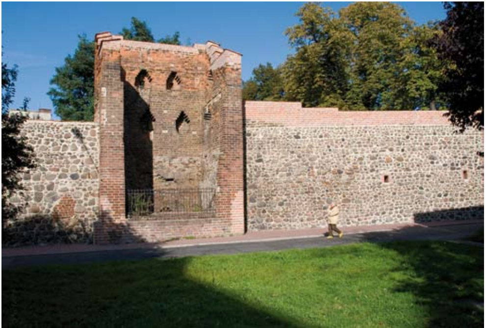
4. Gorzów Wlkp. Fragment muru obronnego / Fragment der Wehrmauer
