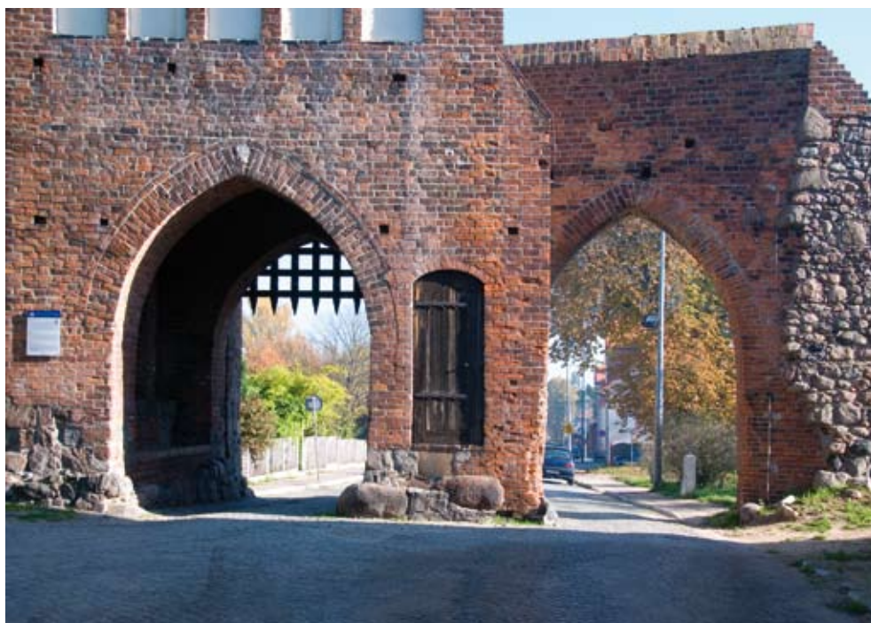
129-130. Strzelce Krajeńskie. Fragment murów obronnych z Basztą Młyńską Fragment der Wehrmauer mit Mühlenturm
