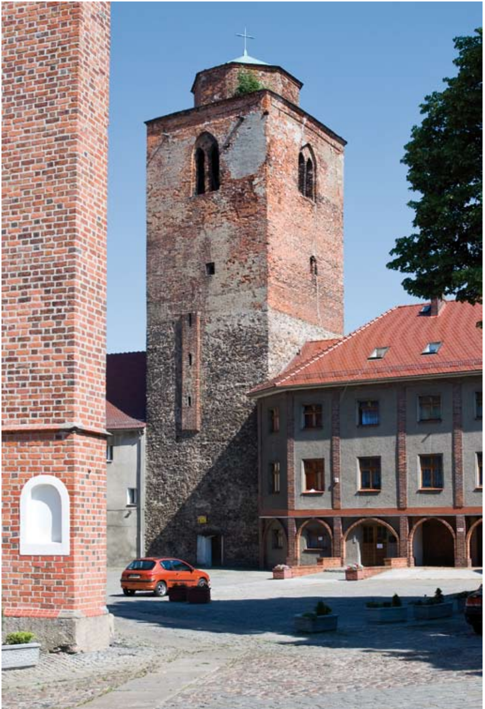
4. Żary. Dawna baszta obronna / Alte Wehrbastei
