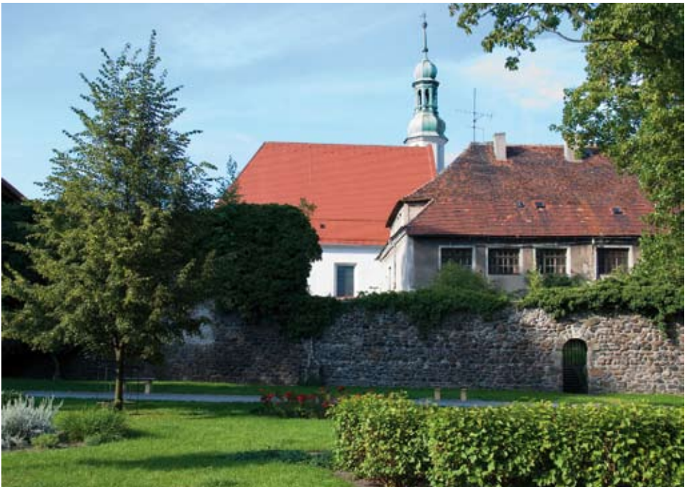
1-2. Żary. Mur obronny, dawna słodownia i kościół pw. Krzyża Świętego Wehrmauer, alte Mälzerei und die Kirche zur Erhöhung des Heiligen Kreuzes
