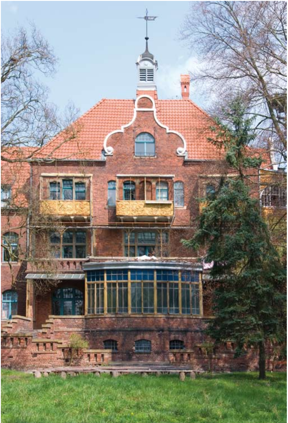
58. Trzebiechów. Jeden z budynków dawnego sanatorium Eines von Gebäuden des ehemaligen Sanatoriums
