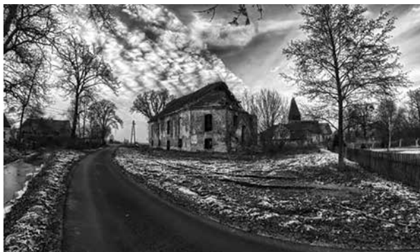
Widok na kościół rzymskokatolicki i ewangelicki w Przeclawiu 21
