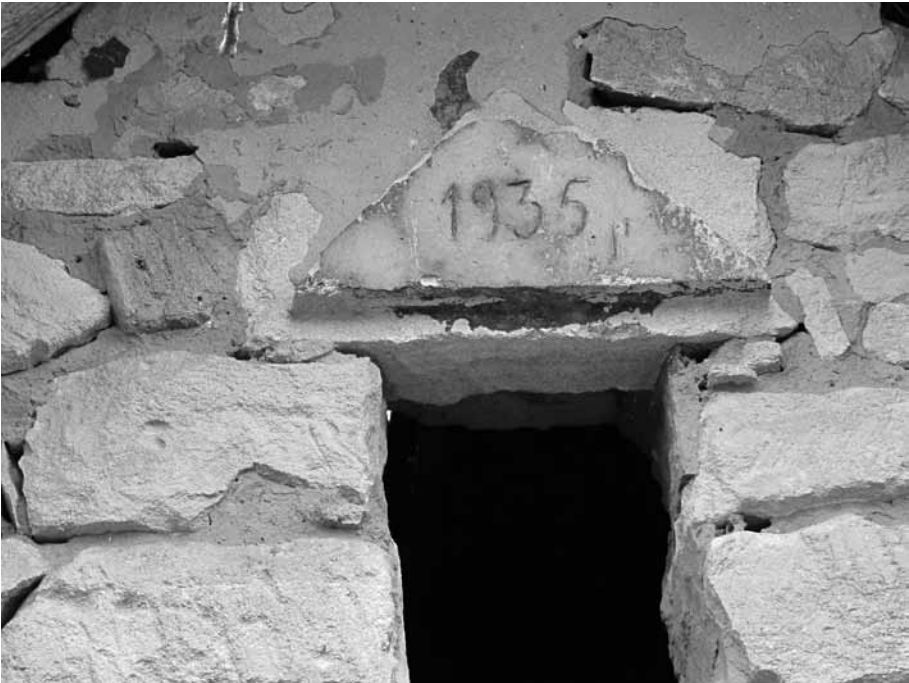
Szczytowa ściana domu Antoniego Sawrasa, wybudowanego w 1935 r.
